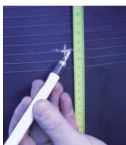
Vyznačte výšku středu připojení
