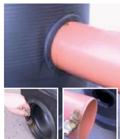
Připojte požadované potrubí
