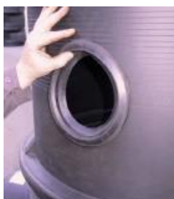
Nainstalujte gumovou manžetu
