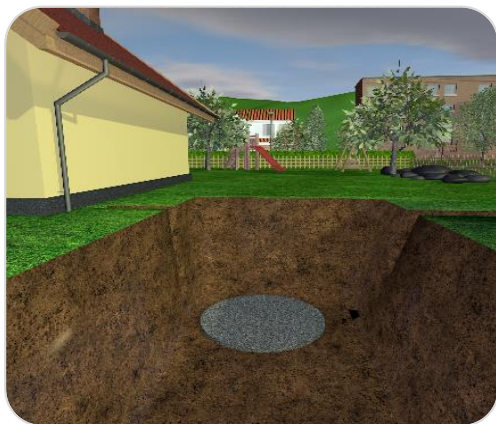
Obr. a1) Zhutněné štěrkové lože
