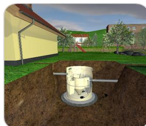
Obr. a4) Připojení nátokového a odtok. potrubí
