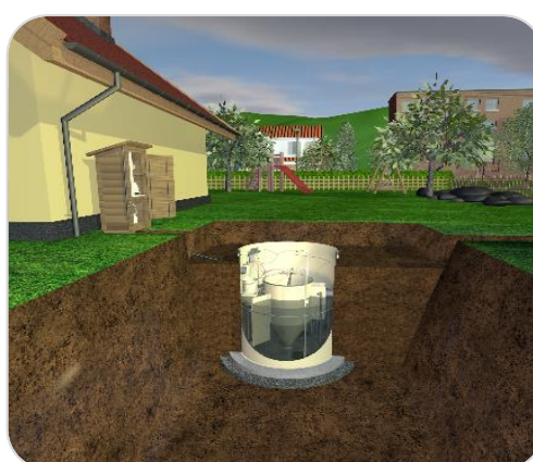
Obr. a6) Napouštění a obsyp ČOV
