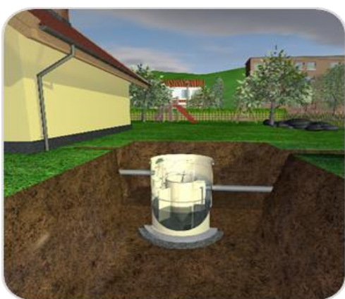
Obr. a5) Napouštění a obsyp ČOV
